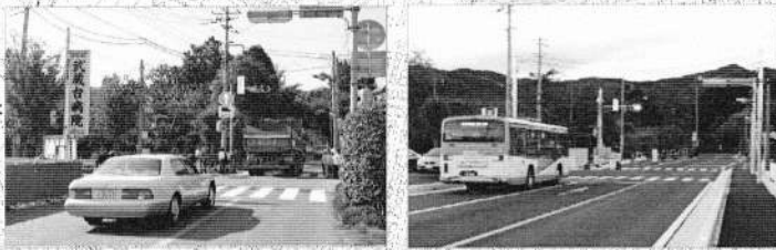
①久保工区(高麗駅入口交差点) 左側:施工前 右側:施工後(H21. 9)
